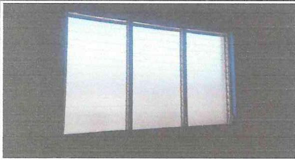
FOTO 3: Los nuevos ventanales ya fueron instalados, para contar con mas resguardo para los estudiantes en todo tiempo. (FINALIZADO)
