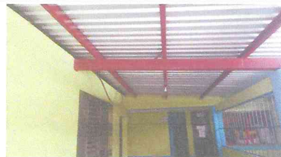
FOTO 2: Las costaneras ya cuenta con el mantenimiento correspondiente para mas tiempo de durabilidad. (FINALIZADO)
