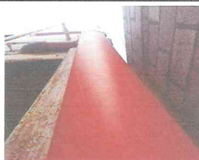
FOTO 4: La terraza de los sanitarios del segundo nivel, ya cuenta con su debida bajada de agua para que en tiempo de lluvia no guarde acumulación de agua. (FINALIZADO)
