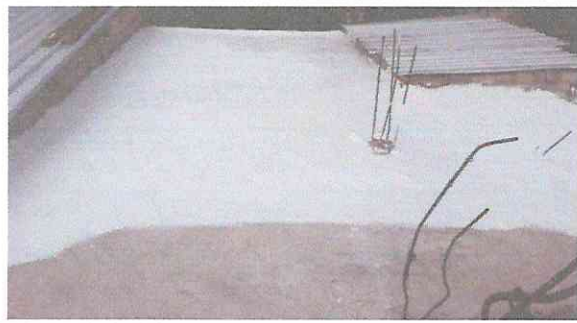
FOTO 1: La terraza ya cuenta con el mantenimiento debido para que el agua no se infiltre a los sanitarios del segundo nivel. (FINALIZADO)
