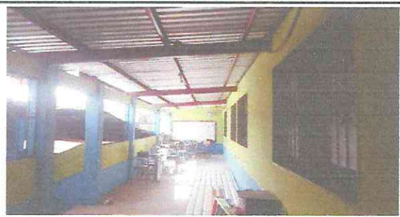
FOTO 5: Los cuatro salones y los dos pasillos ya cuentan con nuevo techado con lámina troquelada aluzic calibre 26. (FINALIZADO)
